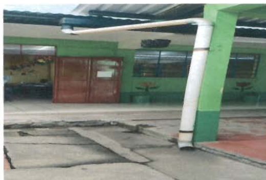
Foto 4: Sustitución de tubería PVC línea principal aguas pluviales MÓDULO 1
