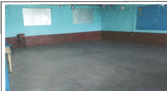
Foto 9: Sustitución de piso cerámico. Aula 6 del MÓDULO 3
