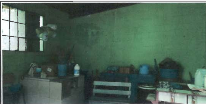
Foto 5: Repello en muro de cocina MÓDULO 1
