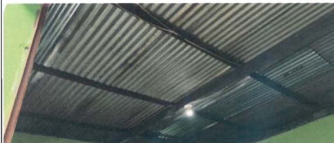
Foto 2: Sustitución de estructura de soporte de madera, por metal MÓDULO 1
