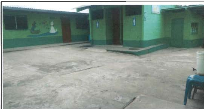
Foto 7: Reparación de planchas de concreto de patio.
