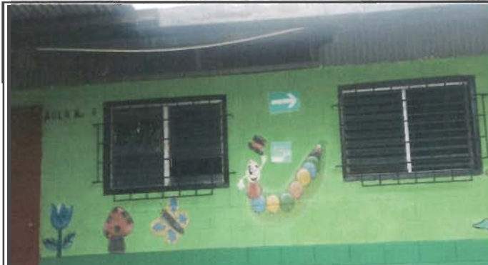
Foto 8: Sustitución de ventanas de metal por PVC MÓDULO 2
