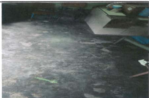
Foto 3: Sustitución de piso cerámico en cocina MÓDULO 1
