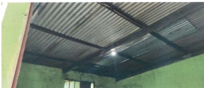
Foto 1: Sustitución de lámina, por lámina troquelada aluzinc calibre 26 MÓDULO 1
